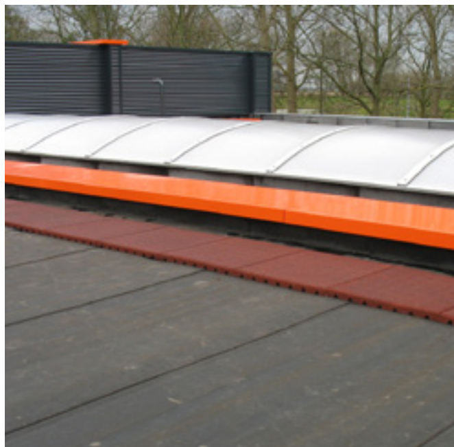
Energydak aangebracht onder dakbedekking.
