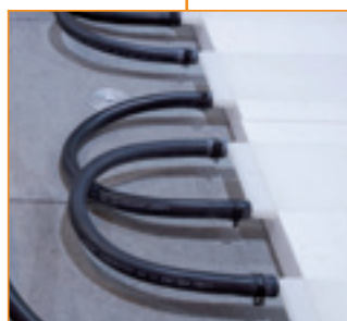
Flexibele koppeling van de collectoren.
